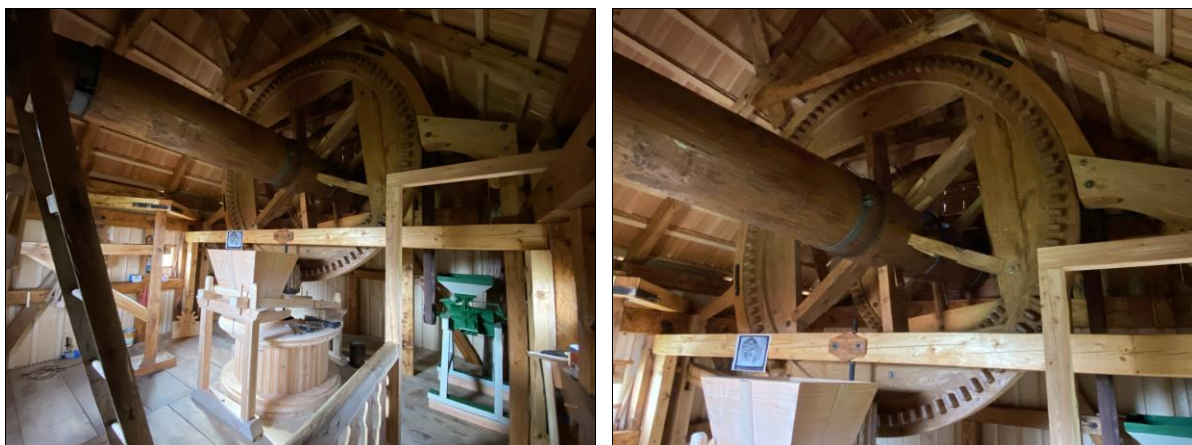
Foto 6-7 Pohled do mlýnice po dokončení mlecího složení, detail palečního kola.
