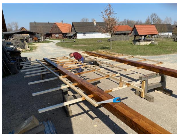
Foto 4-5 Výroba a osazování perutí (duben 2020)
